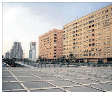
Viviendas de nueva construcción en Valencia.
